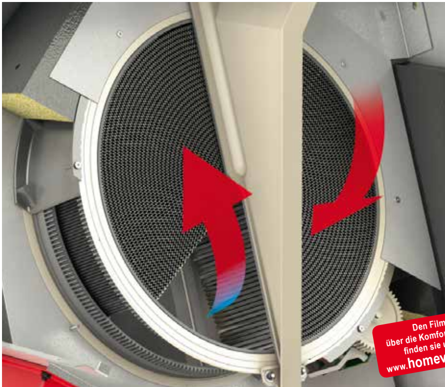
Der patentierte Enthalpierückgewinner im HomeVent® sorgt für einen kontrollierten Wärme- und Feuchteübertrag von der Abluft auf die Zuluft.
