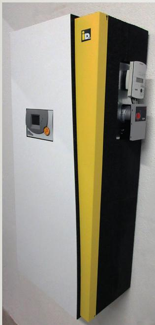
Wenn die Frischwasserstation ohne Navigator-Regelung betrieben werden soll, besteht die Möglichkeit als Regelung eine **UVR 61-3 HEP** zu verwenden.
